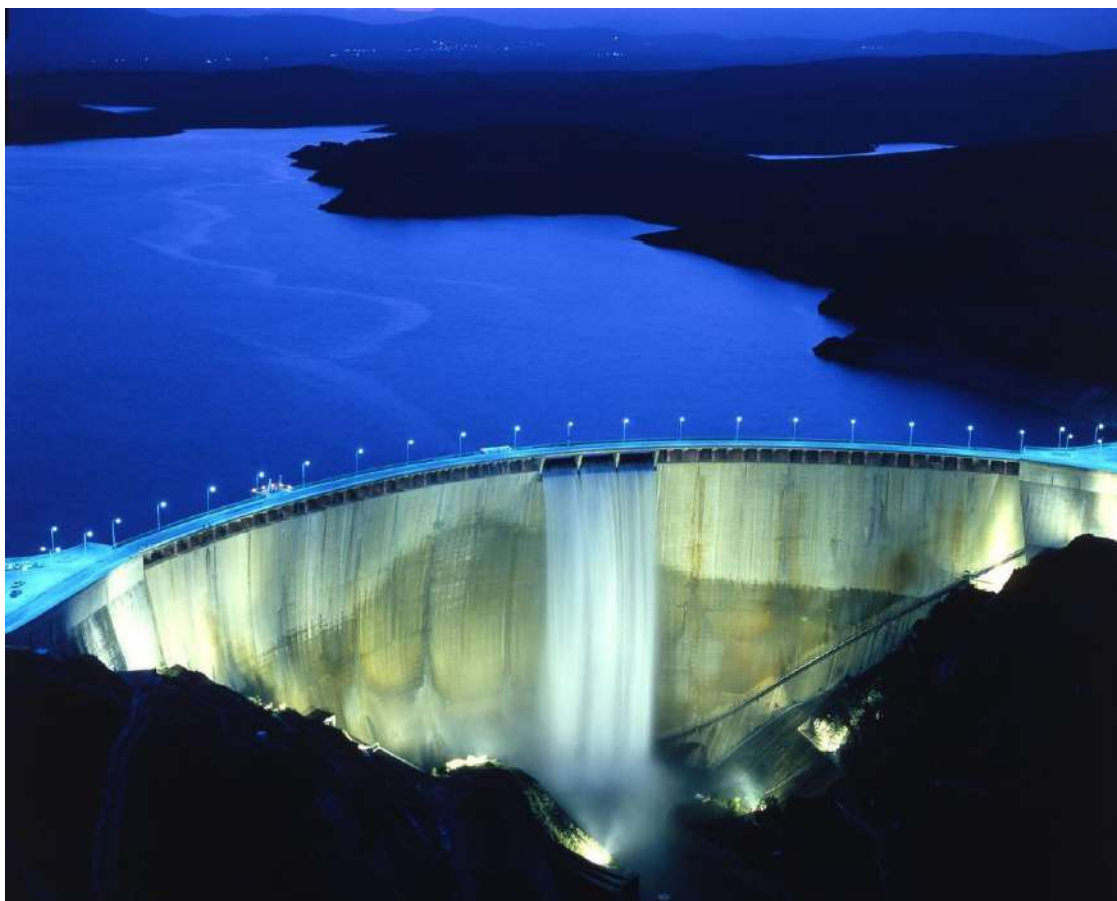
La instalación cuenta con un sistema de auscultación permanente y un entramado de ocho kilómetros de galerías
