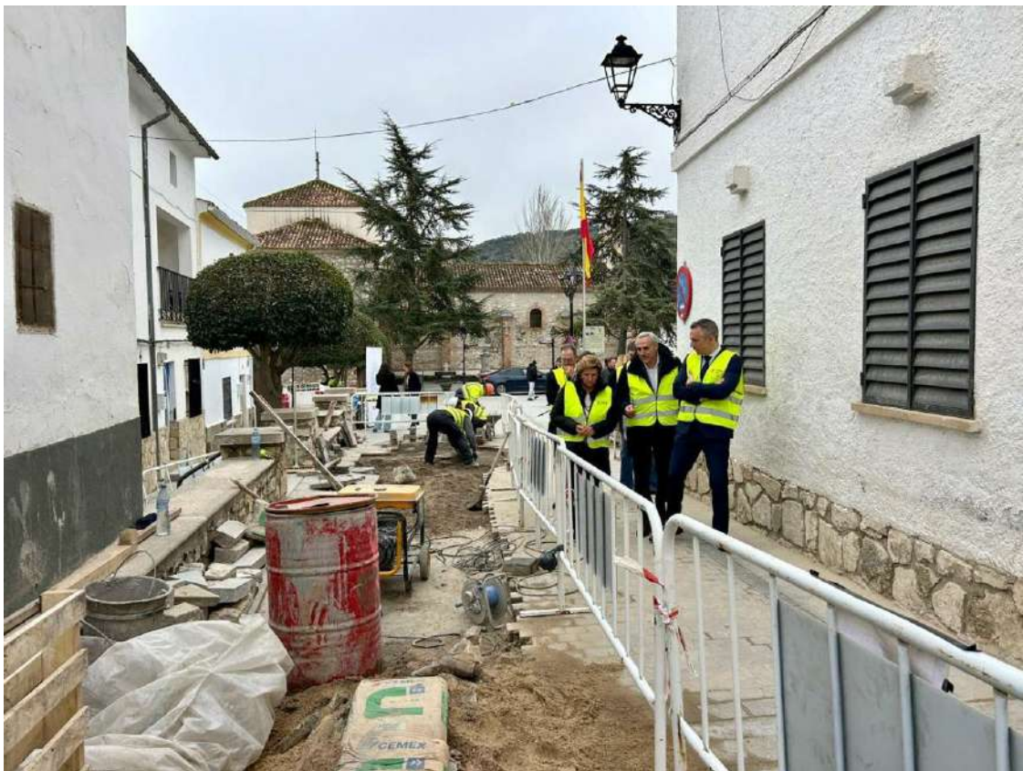
Novillo visita en Villar del Olmo el comienzo de obras del Plan Sanea 2500 del Canal de Isabel II.
